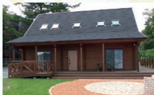
スペンサーロッジ(山中湖畔側)
